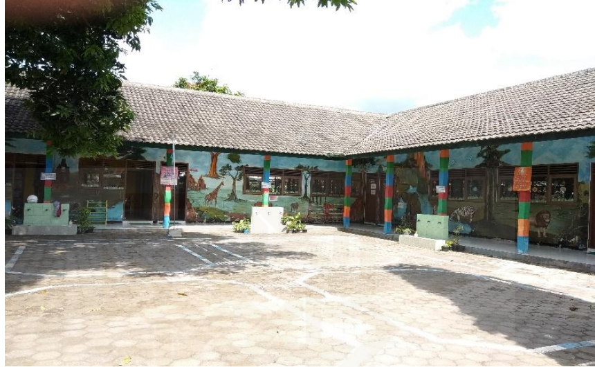
Tampak depan TK ABA Karangasem
