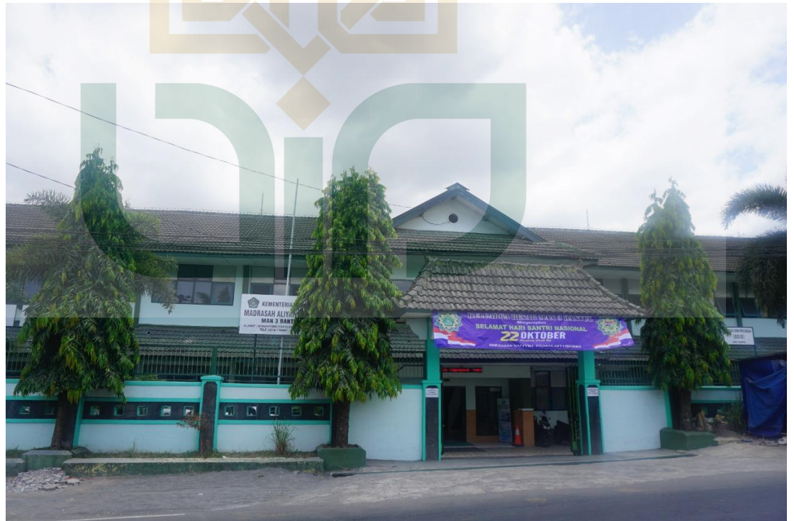
Dokumentasi Tampak Depan gapura MAN 3 BANTUL
