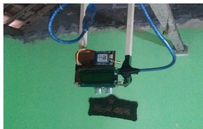
Gambar 6.3. Pemasangan Alat Deteksi
