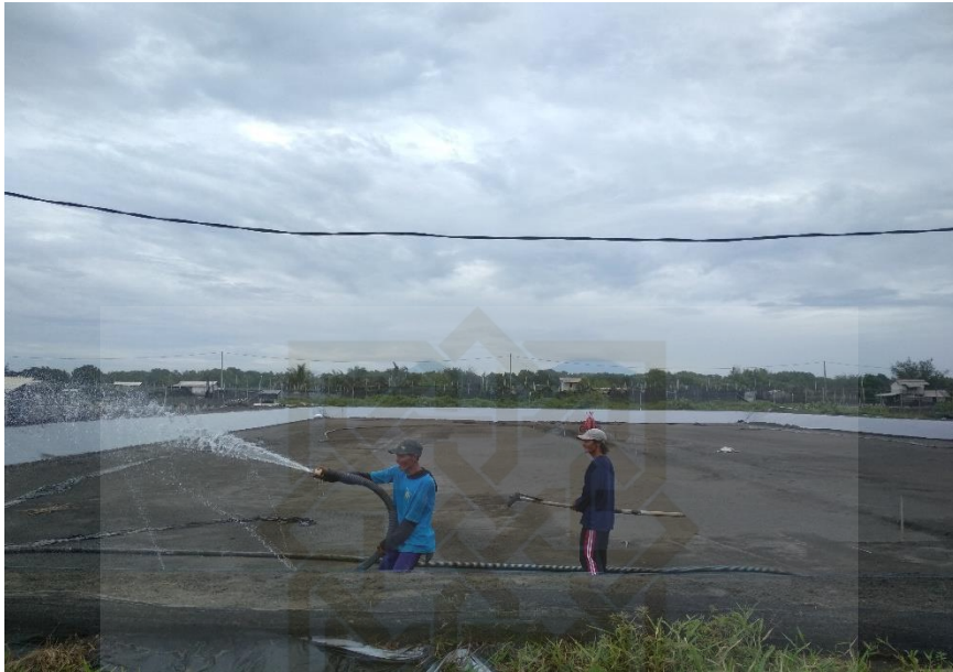
Aktivitas pembersihan kolam tambak pra pemasangan mulsa (plastik penahan air) di area pertambakan Desa Munggangsari.
