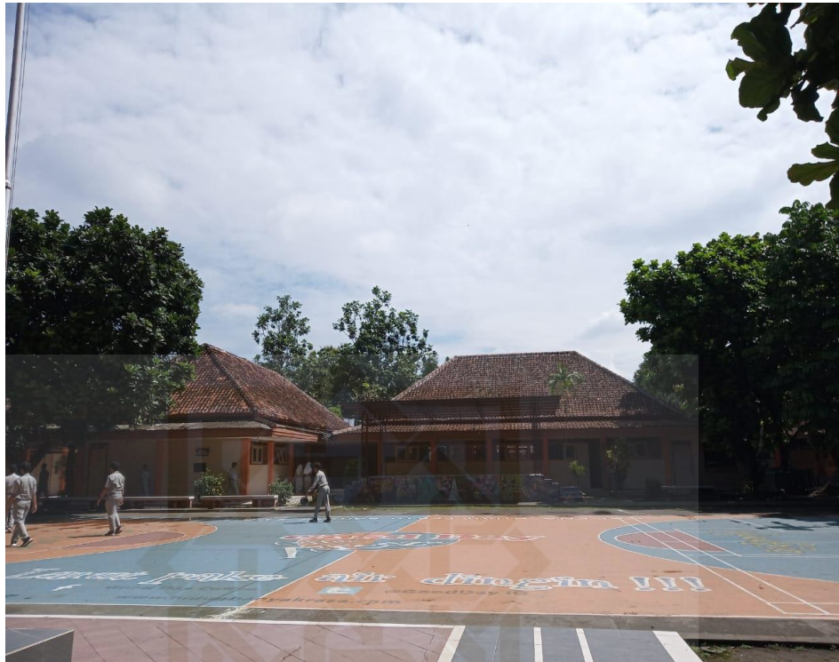
Gambar I Fisik Bangunan SMP N 4 Depok Sleman
