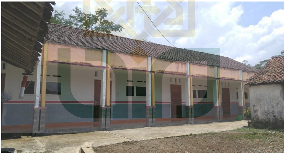
Foto gedung Madrasah Diniyah Muhammadiyah Bojanegara sesudah di renovasi
