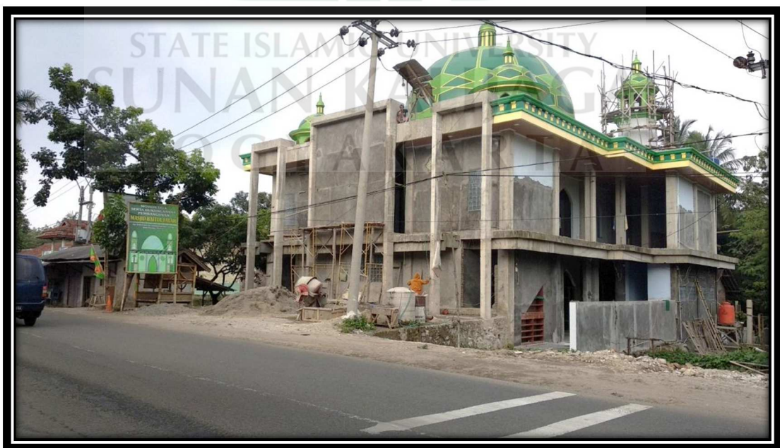
Gambar 2. Kini, Bangunan Masjid Baitul Falah Kemanisan Saat Proses Renovasi.
