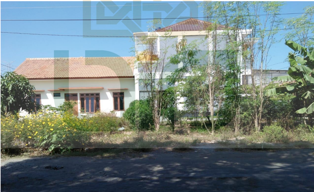
Dokumentasi: Salah Satu Model Bangunan Rumah di Relokasi Bapangan, Desa Glagah
