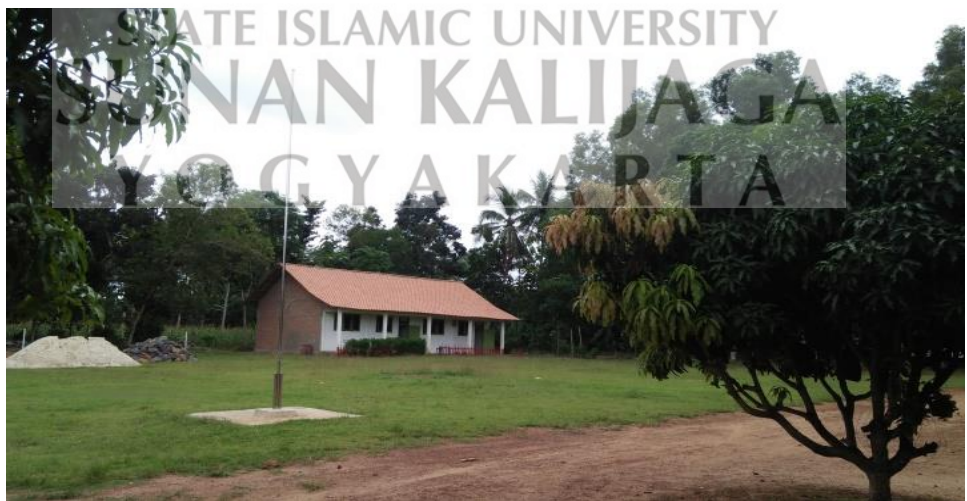
Kondisi gedung dan halaman SMP Sains Qur'an Minhajuth Thullab
