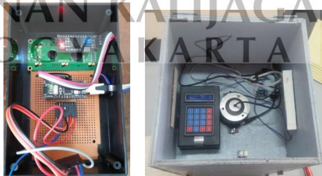
Gambar 6 Proses pengecekan sistem pengatur intensitas cahaya
