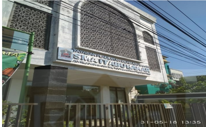
Gambar 01. Tampak Depan SMA IT Abu Bakar Yogyakarta
