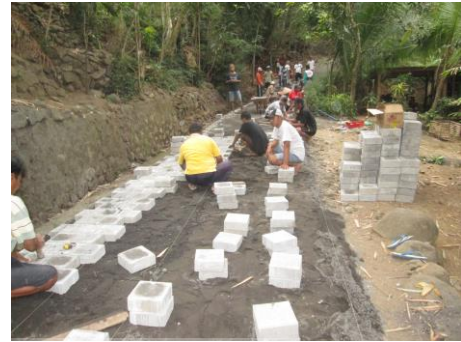
Pavingblok Jalan Dusun
