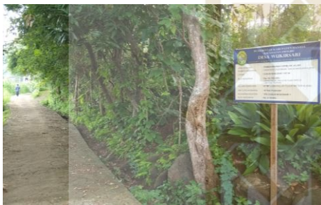
Pemasangan Papan Kegiatan
