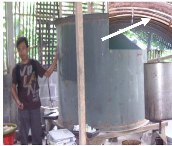
Gambar Pipa stainless steel sebagai kondensasi
