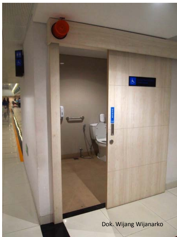
Gambar 7 Pintu Aksesibel menggunakan pintu geser
