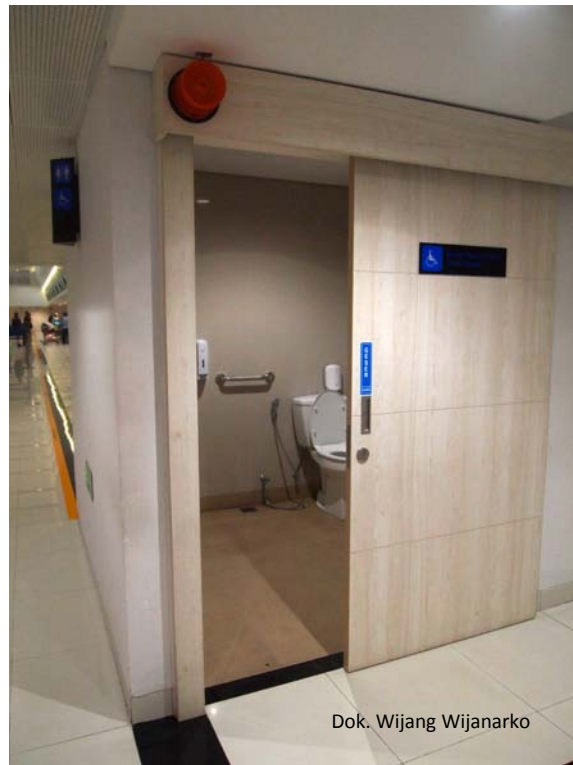
Gambar 7 Pintu Aksesibel menggunakan pintu geser
