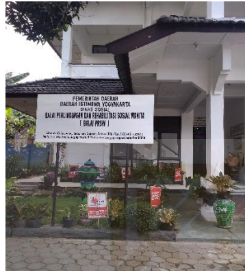
Kantor Balai Perlindungan dan Rehabilitasi Sosial Wanita Yogyakarta
