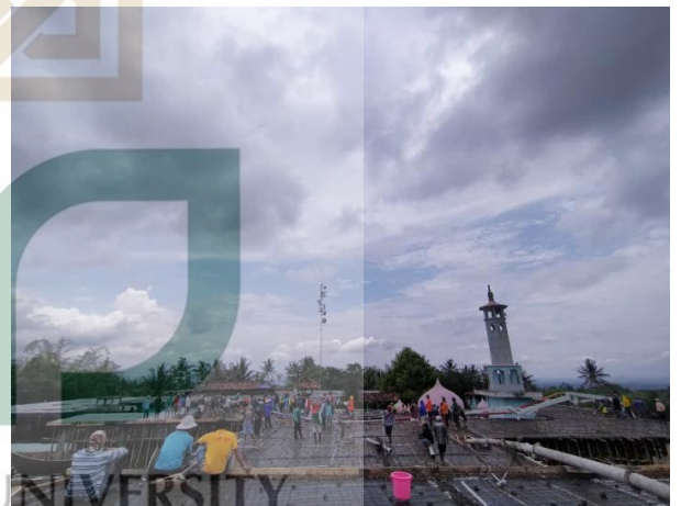
Kegiatan ngecor lantai atas pondok putri Pesantren Al-Qodir
