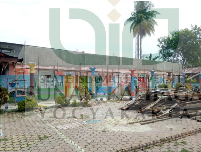
Gedung Sekolah yang Sedang Direhabilitasi
