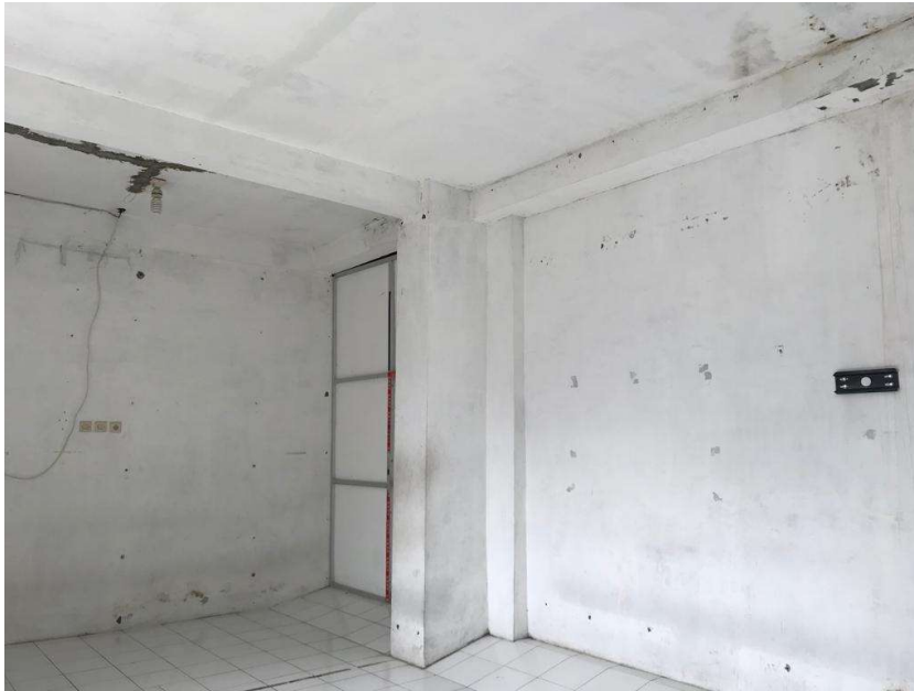
Gambar 4 Sebelum penataan tata ruang
