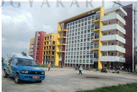
Gambar 2: Gedung dan mobil perpustakaan keliling DPAD Sumber: Dokumentasi Pribadi Peneliti (2021)
