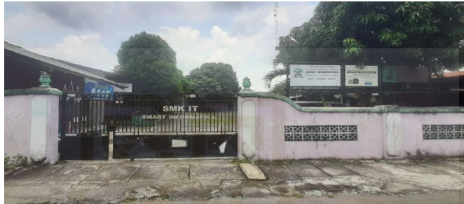
Gambar 4.3. Gedung SMKIT Solopeduli
