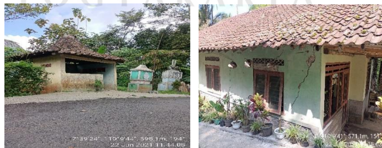
Gambar 1.1 Kerusakan Akibat Tanah Longsor di Dusun Tulangan
