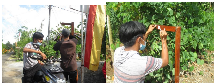
Gambar 2.12 Pembuatan dan Pemasangan Plang Penunjuk Jalan
