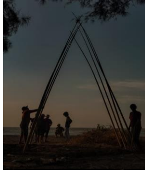
Gambar 1: proses pembangunan gapura masuk pantai cemara kasih
