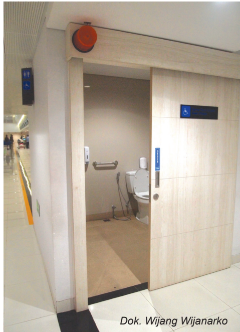
Gambar 7 Pintu Aksesibel menggunakan pintu geser
