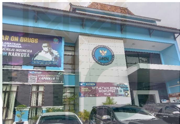
Gambar 1.2 Gedung BNNP DIY
