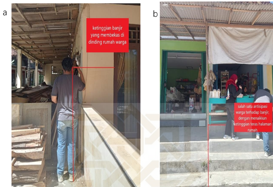
Gambar 1.3 Fakta lapangan kejadian banjir di Desa Hargomulyo (a) Ketinggian banjir yang membekas di dinding rumah warga, (b) Salah satu antisipasi warga terhadap banjir, dengan menaikkan ketinggian teras halaman rumah.
