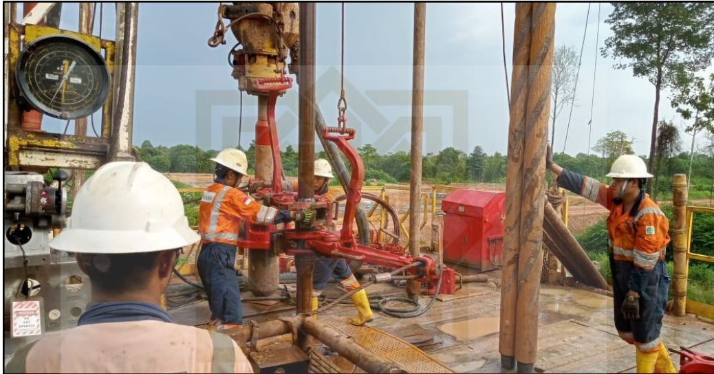
Gambar 1. 2 Pekerjaan Drilling Job Sumber: PT. API (2024)
