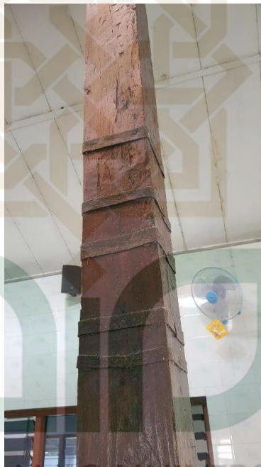
Gambar 1. 1 Detail Permukaan Saka Guru Masjid Kedondong (Sumber: Koleksi Pribadi Nur Indah Lestari)
