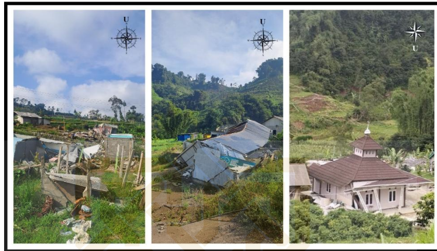
Gambar 1. 3 Dokumentasi rumah rusak akibat tanah bergerak (Dokumentasi Lapangan, 2025)
