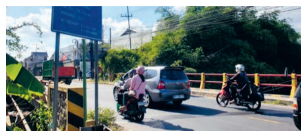
BAKAL DIPERBAIKI: Kondisi arus lalu lintas di Jembatan Gondang di jalur nasional Tulungagung-Trenggalek kemarin (31/5).
