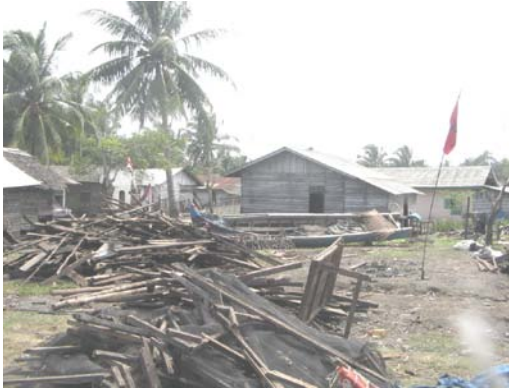
Gambar kerusakan tsunami 12 September 2007 di pantai Pasir Indah Mukomuko (sumber BMKG, 2007)
