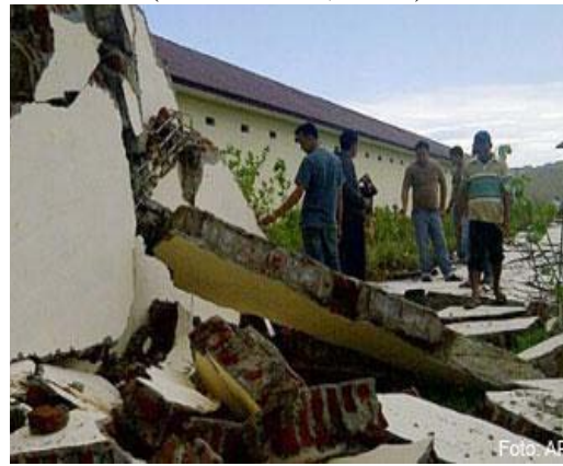
Kerusakan gempa 11 April 2012 (sumber BMKG, 2012)
