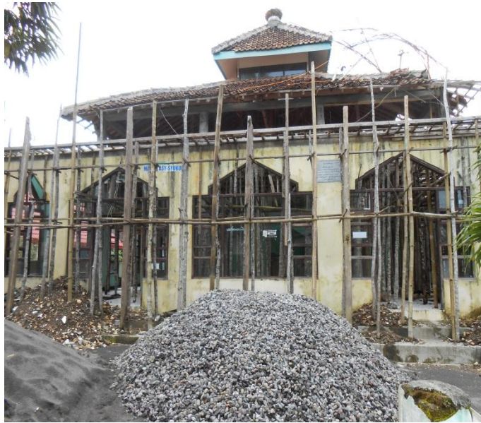
Renovasi Masjid Syukur di Dusun Terasih Desa Giri Asih
