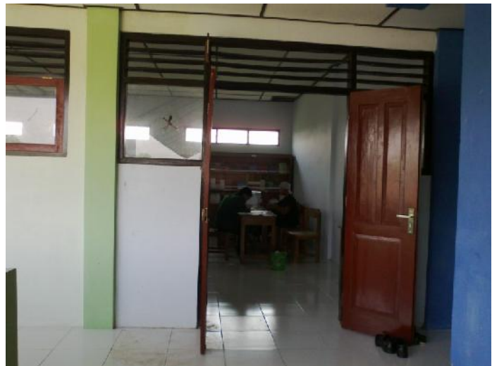
Pintu masuk perpustakaan
