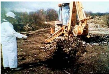
Limbah dibuang di suatu tempat penampungan, kemudian dipadatkan dengan traktor, lalu ditutup tanah. Pada bagian dasar tempat tersebut dilengkapi dengan sistem saluran yang berfungsi sebagai saluran limbah cair sampah yang harus diolah terlebih dahulu sebelum dibuang ke sungai. Cara pengolahan limbah seperti ini disebut ....
