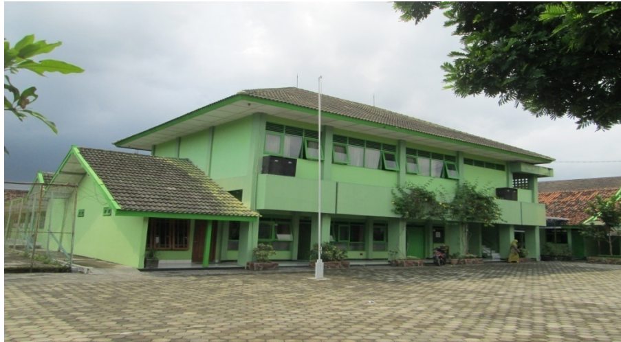
Gedung ruang kepala sekolah dan TU MAN
