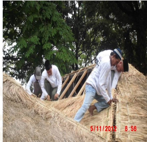
Foto: 2. Pemasangan welit dari luar
