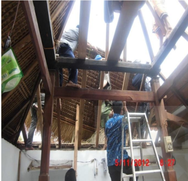
Foto: 1. Pemasangan welit dari dalam
