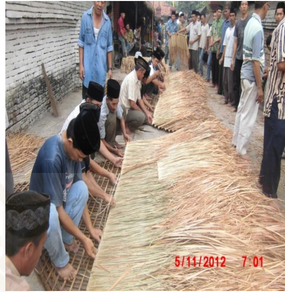
Foto: 6. Warga sedang memasang welit baru ke atap bambu pada saat upacara memayu
